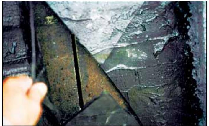
**Figure 4** Défaillance d'adhésion de la membrane en service
