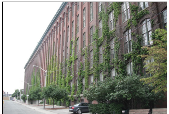
Figure 7 Toronto - utilisation de plantes grimpantes sur les façades d'anciens bâtiments industriels convertis en logements; juin 2011.
