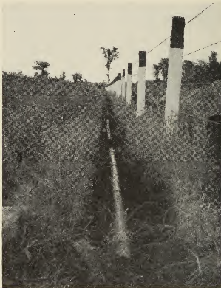
Tuyau de fibre servant au transport de l'eau d'irrigation à la sous-station expérimentale fédérale de Sainte-Clothilde (P.Q.).
