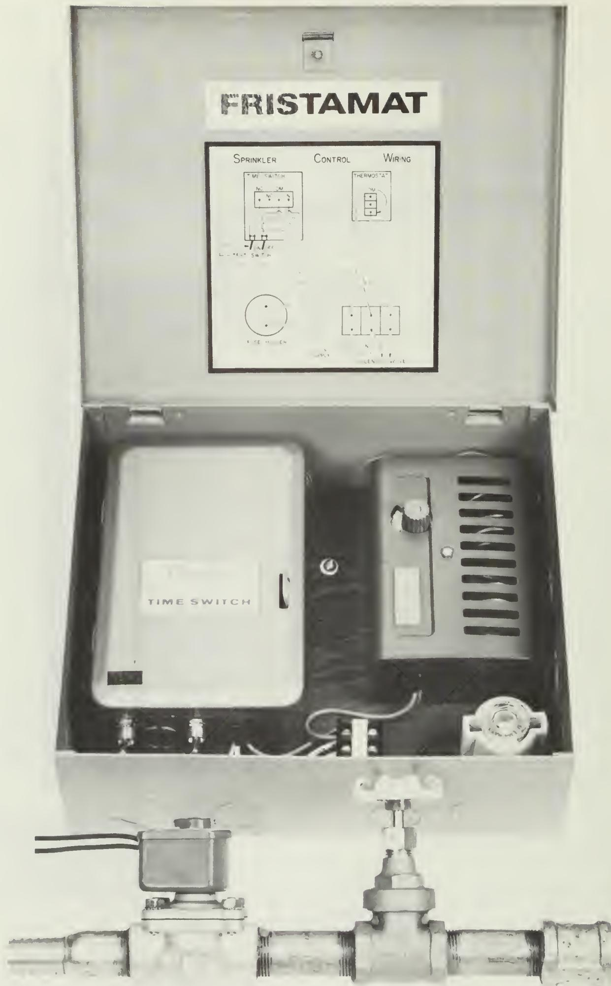
Figure 56 Dispositif de contrôle déjà monté, utilisé pour le rafraîchissement par arrosage. Reproduction autorisée par Fristamat Ltd.
