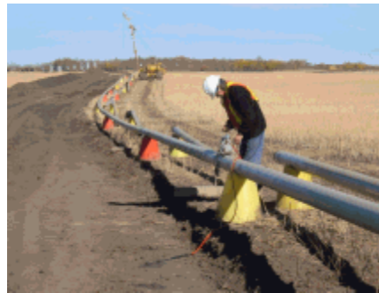
Image 6 : Inspection d'un oléoduc à l'aide d'équipement de gammagraphie industrielle
