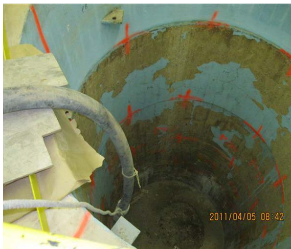
Figure 7.8 – Remplissage de la piscine avec du béton
