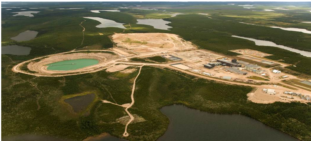
Figure 6.3(a) – Installation de gestion des résidus de la mine JEB à McClean Lake
