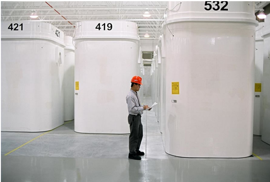
Figure 4.4 – Conteneurs de stockage à sec à une installation de gestion des déchets d’OPG
