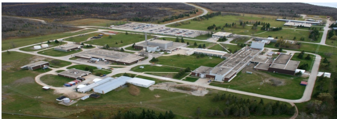
Figure 7.1 – Vue aérienne du site principal des Laboratoires de Whiteshell (2010)
