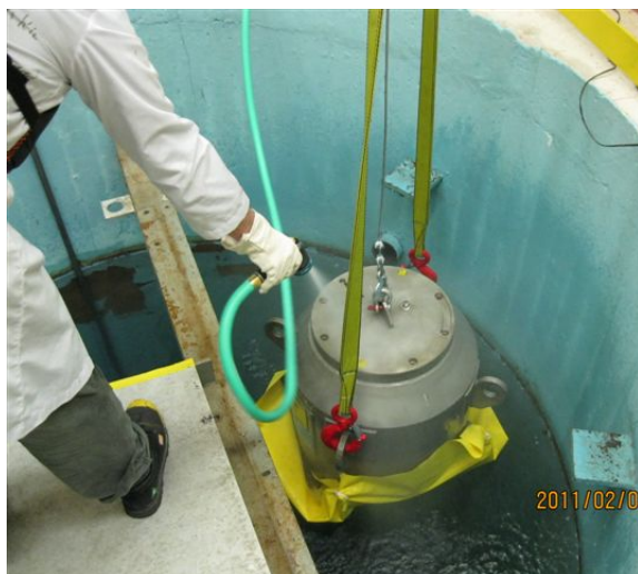
Figure 7.7 – Enlèvement du château de transport du cœur chargé d'uranium hautement enrichi de la piscine du réacteur
