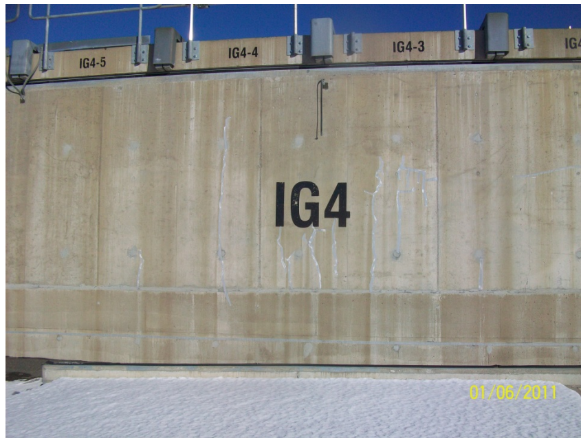
Figure 5.4 – Structure de stockage en voûte de Point Lepreau
