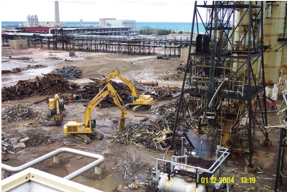
Figure 7.5 – Démolition du site de l'usine d'eau lourde de Bruce
