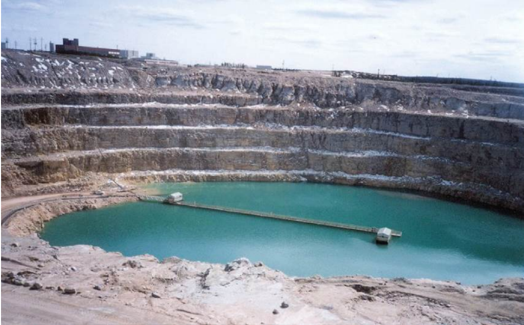
Figure 6.3(b) – Installation de gestion des résidus de la mine JEB à McClean Lake
