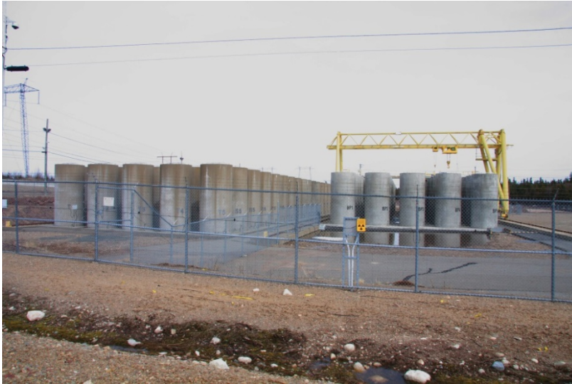
Figure 4.9 – Zone de stockage à sec du combustible utilisé de Point Lepreau
