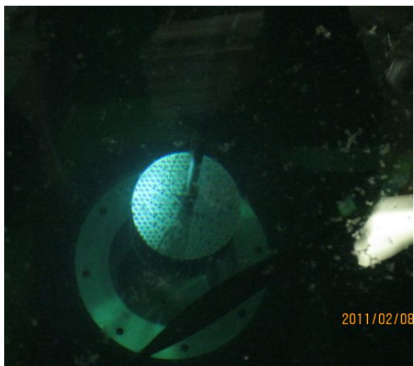
Figure 7.6 – Enlèvement du cœur chargé d'uranium hautement enrichi du contenant du réacteur
