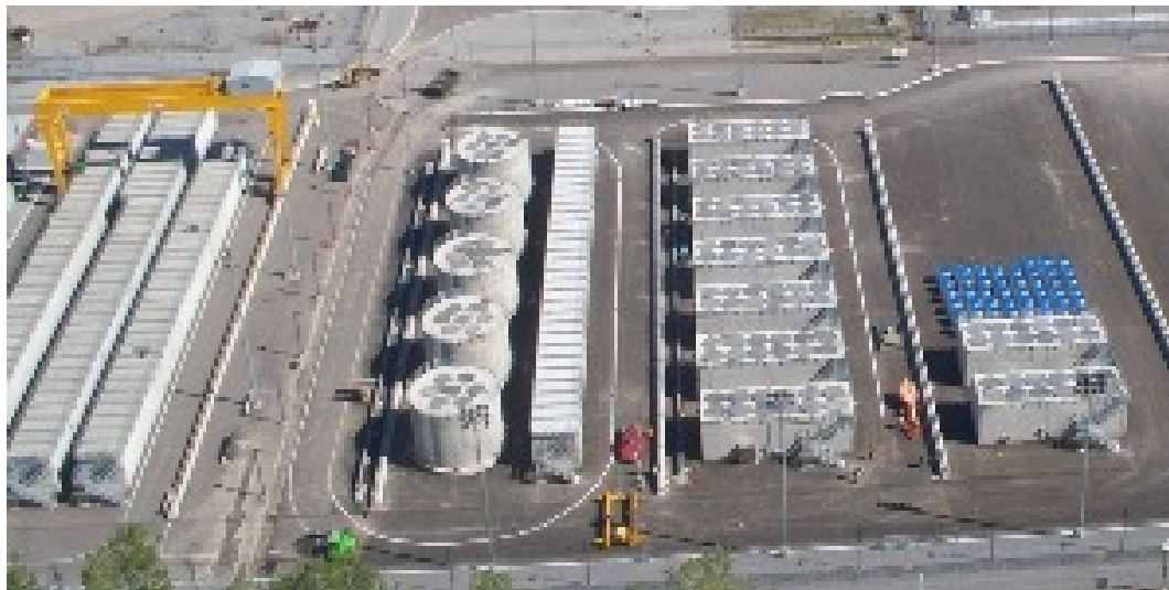
Figure 5.3 – Installation de gestion des déchets radioactifs solides de Gentilly-2
