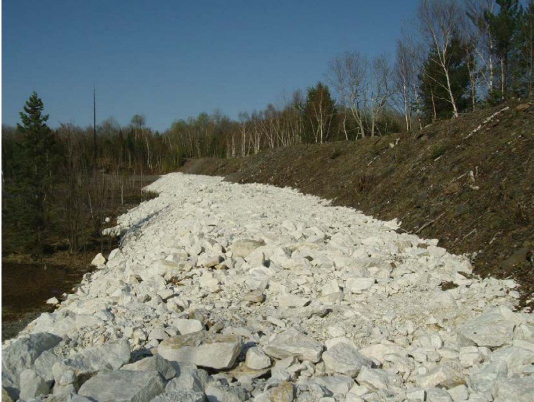
Figure 8.8 – Barrage principal de résidus de la mine Dyno
