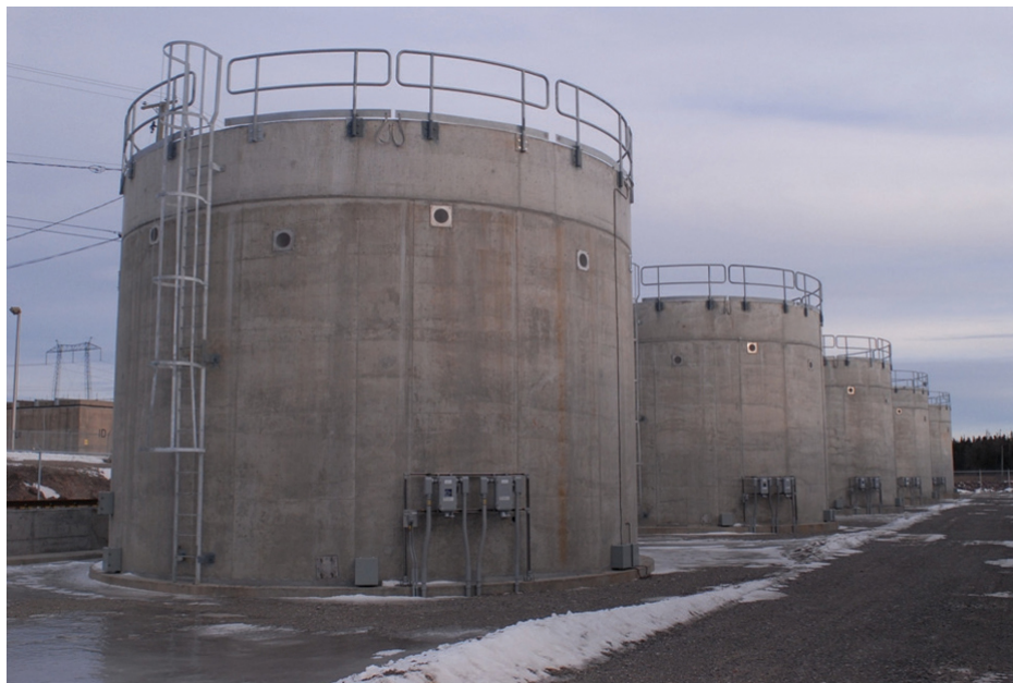
Figure 5.5 – Silos de déchets de retubage de Point Lepreau
