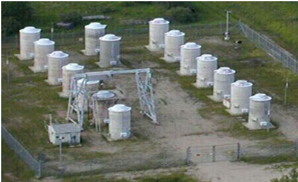
Figure 4.11 – Installation de stockage à sec du combustible usé des Laboratoires de Whiteshell
