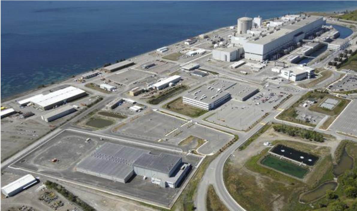
Figure 4.6 – Site de la centrale Darlington avec l’installation de gestion des déchets à l’avant-plan
