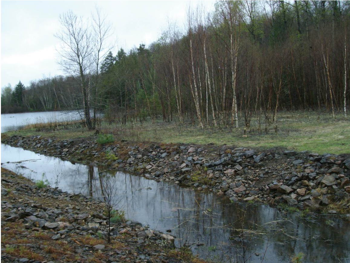
Figure 8.9 – Déversoir du bassin de résidus sud de l'installation de stockage de résidus de Bicroft
