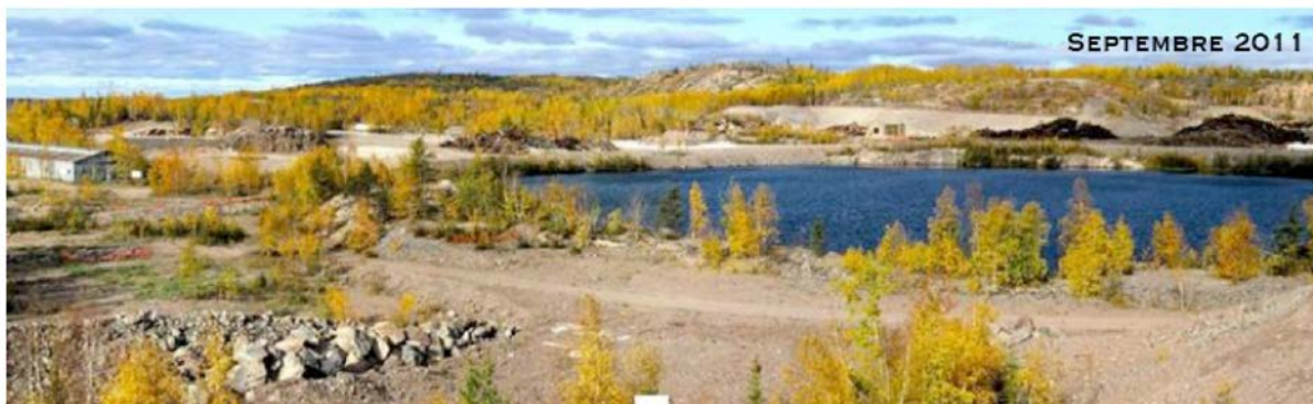
Figure 8.4 – Après l'exécution des travaux ordonnés par la CCSN (septembre 2011)
