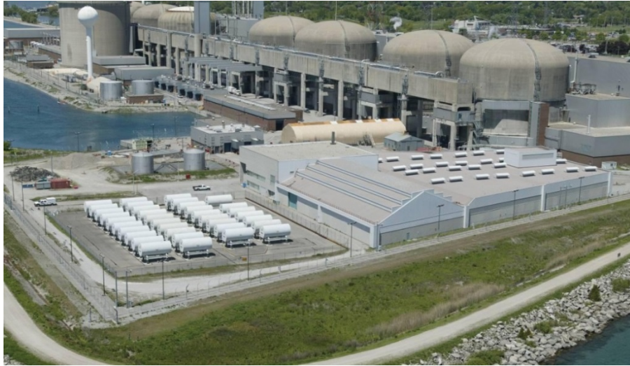
Figure 5.1 – Installation de gestion des déchets de Pickering avec la zone de stockage des composants de retubage (à gauche) et la zone de stockage à sec du combustible utilisé (à droite)
