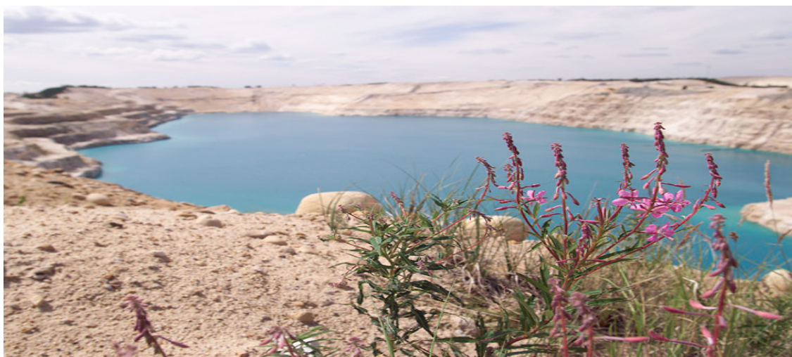
Figure 6.1 – Installation de gestion des résidus Deilmann à Key Lake
