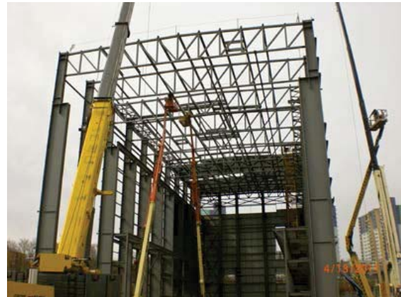
Édification de la charpente à ossature d'acier de la future installation permanente de maintenance de sous-marins à la BFC Halifax
