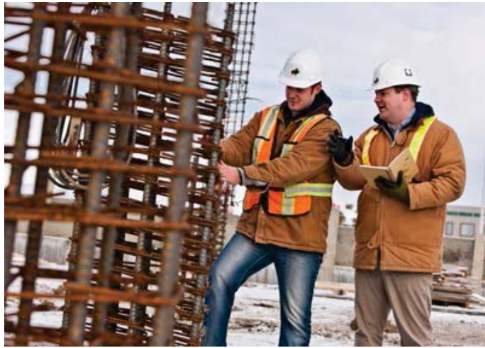
Mark Caffray (à droite) et Mike Painchaud, coordonnateur, Services de construction, inspectent les barres d'armature.
