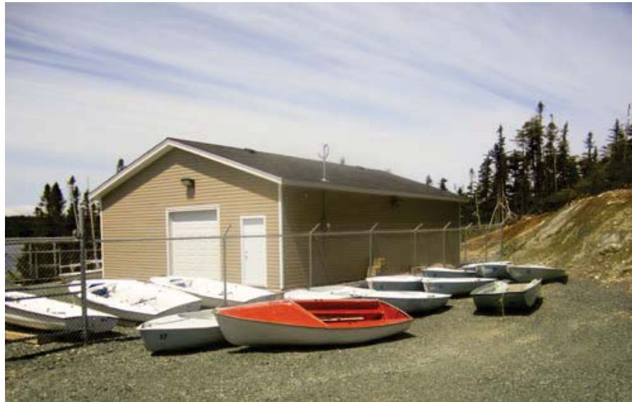
L'installation qui a été construite à Paradise, Terre-Neuve, a été utilisée comme modèle pour le centre de voile de Pasadena.
