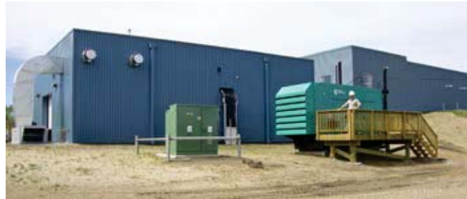
On voit l'usine de traitement de l'eau de Wainwright terminée, de l'équipement de traitement de l'air et la génératrice.
