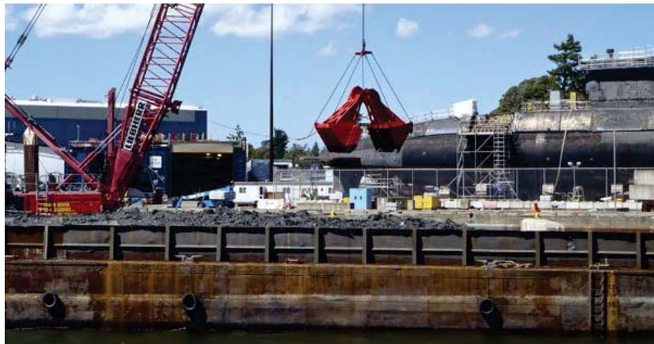
Le dragage des sédiments contaminés du plan d'eau de la cale sèche d'Esquimalt. Les matériaux extraits seront transportés du site dans des barges à une installation de déchargement.
