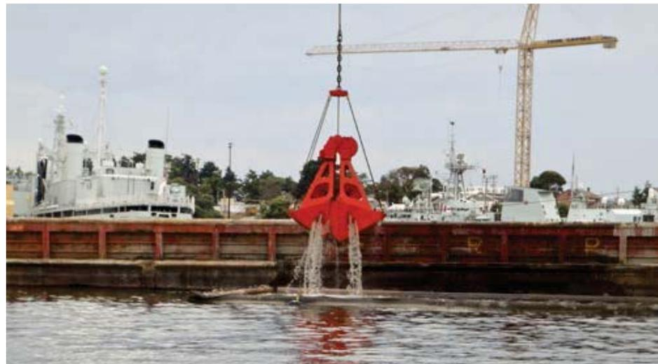
Le dragage des sédiments contaminés du plan d'eau de la cale sèche d'Esquimalt. Les matériaux extraits seront transportés du site dans des barges à une installation de déchargement.
