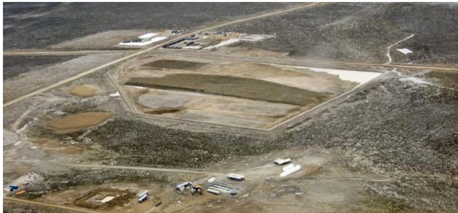
Vue d'une aire de traitement de sols contaminés (endroit où l'on traite les sols contaminés aux hydrocarbures (carburant)) à Cape Dyer.
