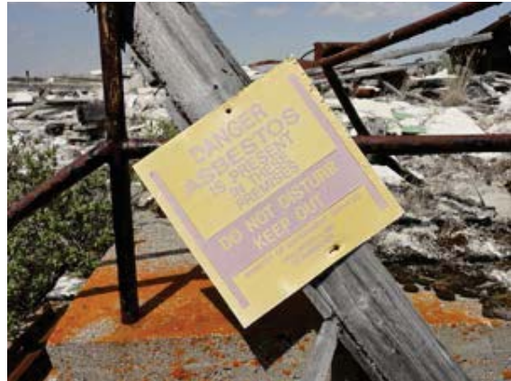
Un panneau au site de la Ligne de radars du Centre du Canada avertit la présence d'asbestos dans les débris de démolition d'un bâtiment effondré.
