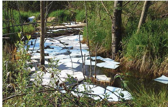
Des tampons absorbants contre les déversements sont déployés pour limiter la propagation de carburant dans l'eau.
