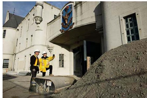
Steven Denault, chef d'équipe, Services de construction (gauche) et Julien Wong, coordonnateur, Services de construction, sont deux employés de CDC à avoir travaillé à la réfection et à la mise à niveau selon les normes sismiques du Manège militaire Seaforth Armoury, à l'ouest du trépidant secteur de Burrard Street Bridge de Vancouver.
