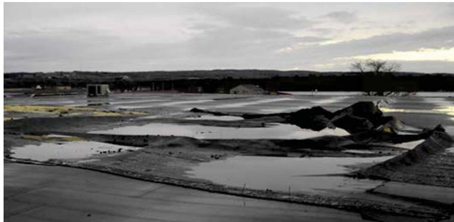
Dommages au toit du hangar 5 à la 14 e escadre/BFC Greenwood.
