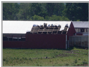
Ci-dessus : Dommages causés par une microrafale le 28 juillet à Albion, au Maine (Source : John Jensenius)
