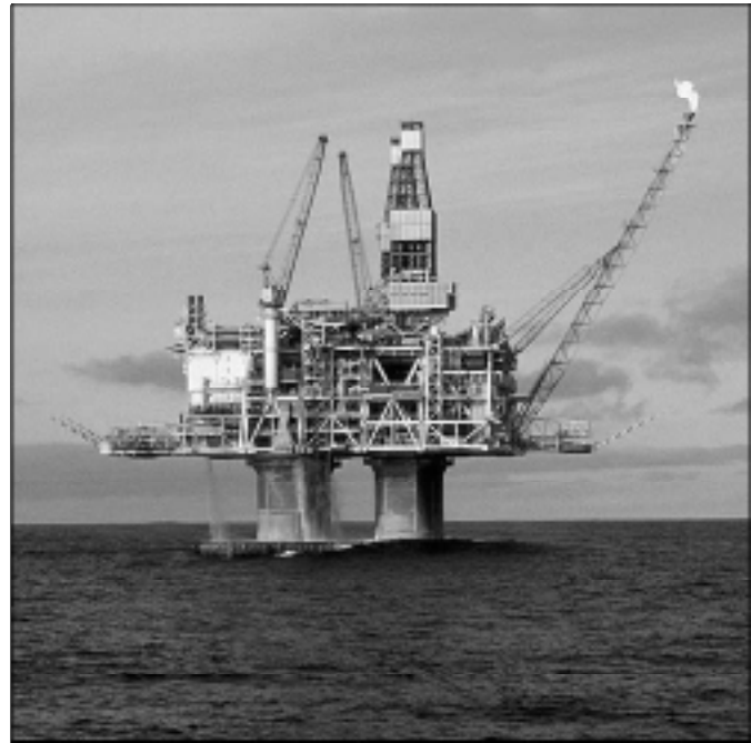
L'appareillage électrique moyenne tension est utilisé avec succès par les plates-formes de forage en mer comme Hibernia . (Photo par Hibernia )
