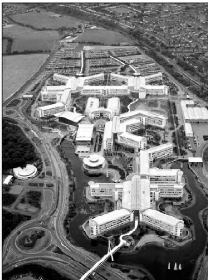
Vue aérienne des installations extensives d'Abbey Wood à Bristol, R-U.
