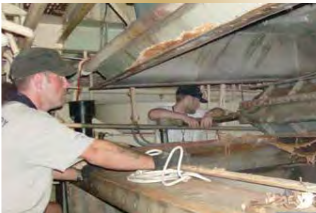
Figure 6 – En déplaçant vers l'avant le joint de dilatation du système d'échappement, le monteur Spartius Toope (à gauche) et le tôlier Ryan Shaw de l'IMFCS ont créé le dégagement nécessaire pour qu'on puisse faire tourner la conduite d'échappement et la positionner pour son retrait.
