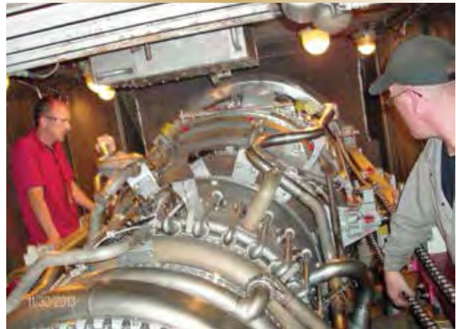
Figure 13 – Le représentant en services de terrain Del Rogers de la General Electric (à gauche) et le mat 1 et technicien en TG de marine John Alford de l'IMFCS relient le générateur de gaz à la turbine de puissance. Le navire a ensuite effectué ses essais en mer des jours avant l'échéance.
