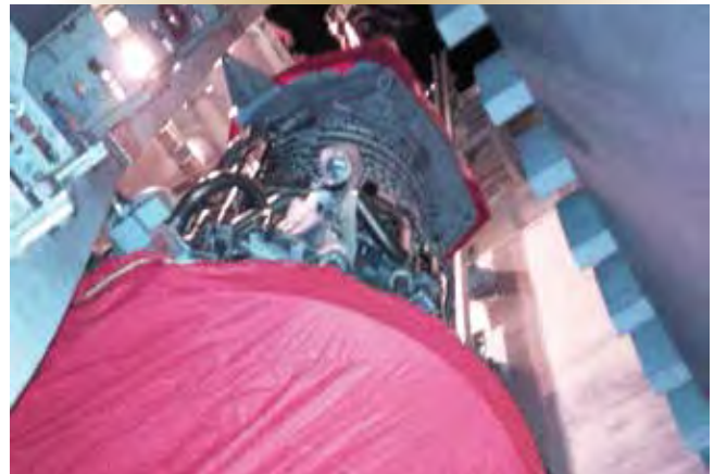
Figure 7 – Le générateur de gaz est hissé hors du collecteur d'admission d'air par une grue à terre.
