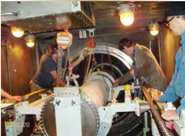
Figure 12 – Le monteur Joshua Gordon et le tôlier Ricardo Green de l'IMFCS et le m1 Steve Beaulieu du NCSM Toronto installent le nouvel arbre d'accouplement haute vitesse.
