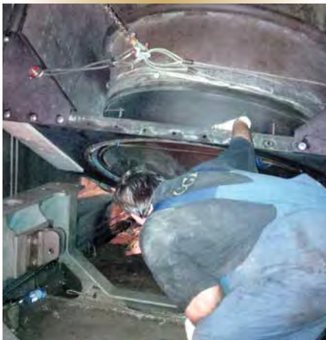
Figure 8 – Le monteur Steve Eddy de l'IMFCS procède au guidage de la conduite d'échappement à mettre en position horizontale.
