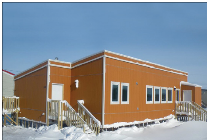
Figure 4 Maison durable construite pour le Nord d'Arviat
