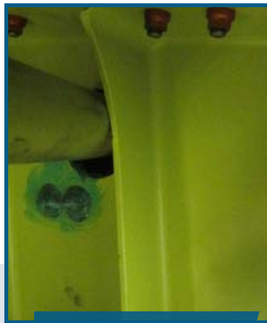
Frottement sur le tuyau intérieur du réservoir de carburant
