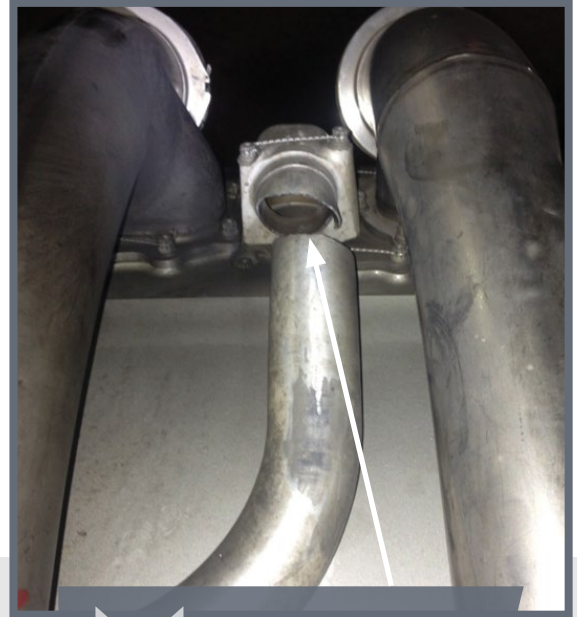
Panneau de décompression de capot moteur manquant et conduit d'antigivrage brisée
