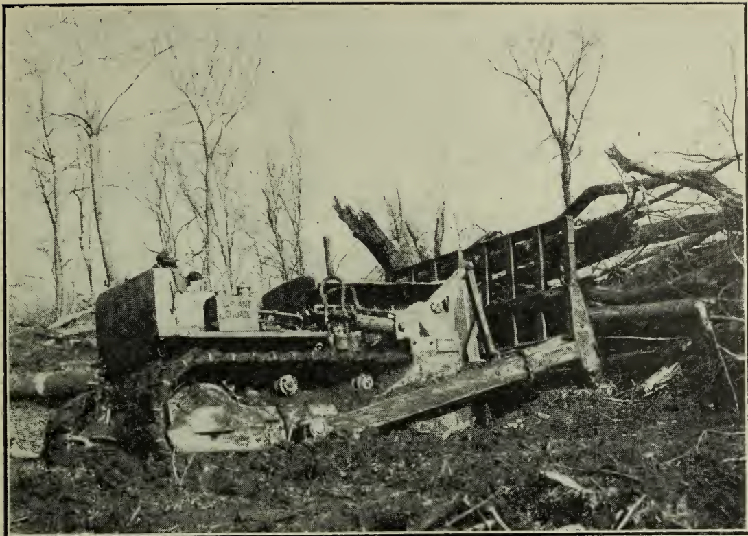
Fig. 12.—Balayeuses mobiles. Les tracteurs munis de couteaux à dents ou de râpeaux à broussaille sont employés pour entasser les broussailles ou balayer les broussailles et les déchets de bois. (Photo par courtoisie de LaPlante-Choate Manufacturing Co. , Cedar Rapids, Iowa).
