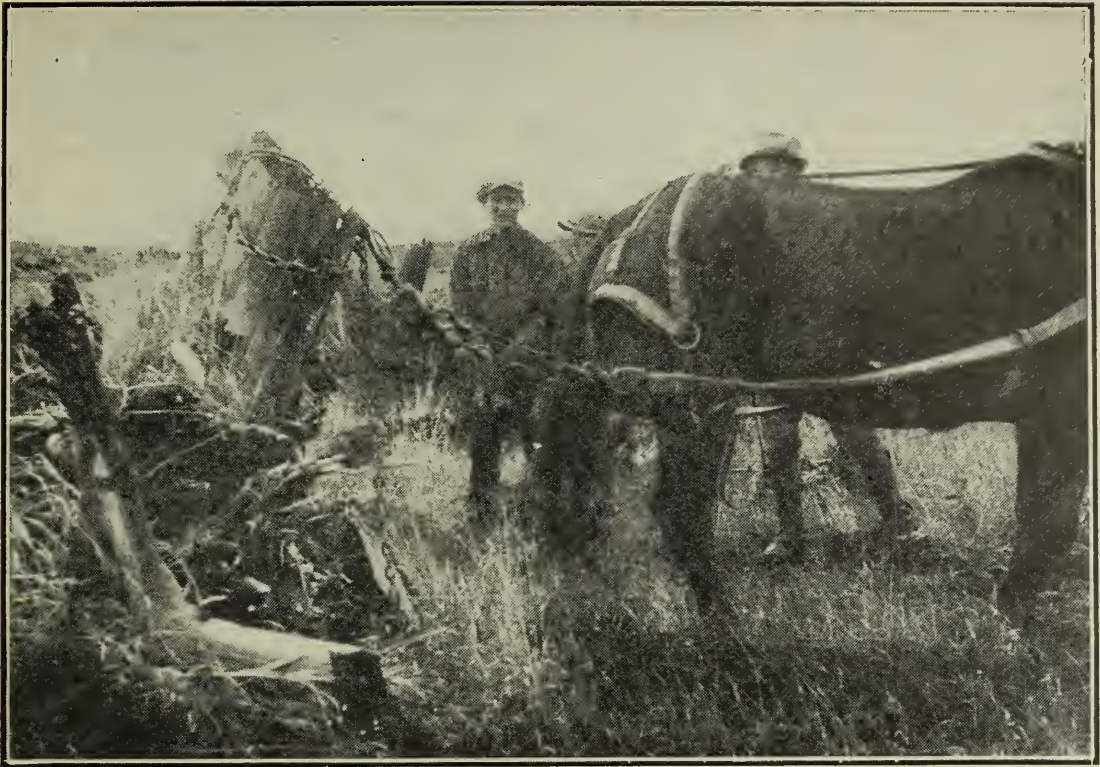
Fig. 4.—Arrachage des souches pourries—Lorsque les souches sont laissées à pourrir pendant plusieurs années, on peut les enlever facilement. Pour l'arrachage, on se sert d'un levier à chaîne élevé.
