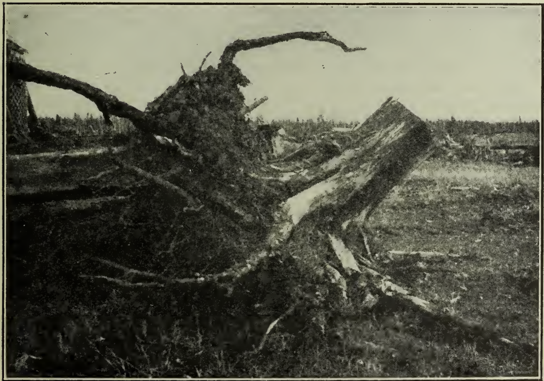
Fig. 15.—Arrachage d'une souche au moyen d'un tracteur-bélier—Après la libération de la souche, la plaque du bélier est abaissée pour atteindre la base de la souche. La plaque est élevée à mesure que la souche sort de terre. La souche représentée dans cette photo a été extraite en 60 secondes.
