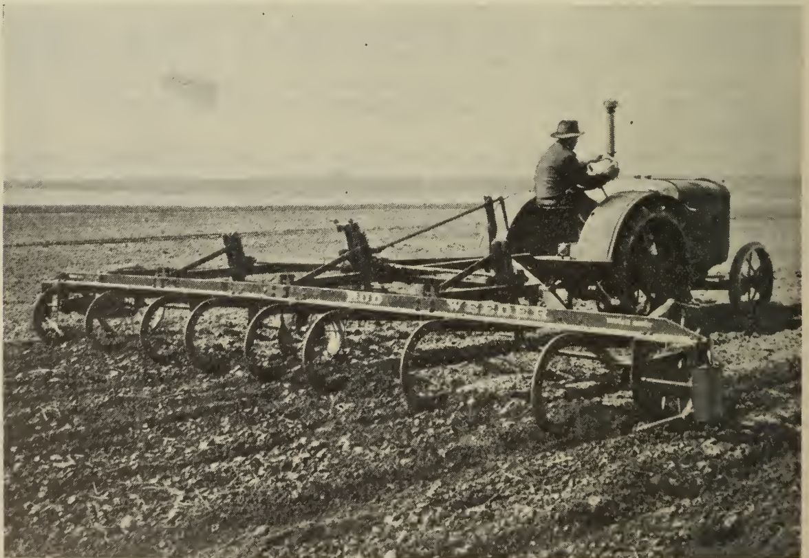
La désherbeuse à barre ( Rod weeder ) fournit un moyen rapide et économique de détruire beaucoup d'espèces de mauvaises herbes sur la terre en jachère d'été.
