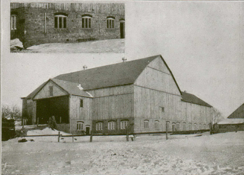
FIG. 65. Grange de Biggar Bros, comté de Halton, Ont. La vignette supérieure à gauche montre les fenêtres ainsi que les conduits d'entrée en métal de l'appareil de ventilation. Aménagement intérieur même que dans la figure 64.
