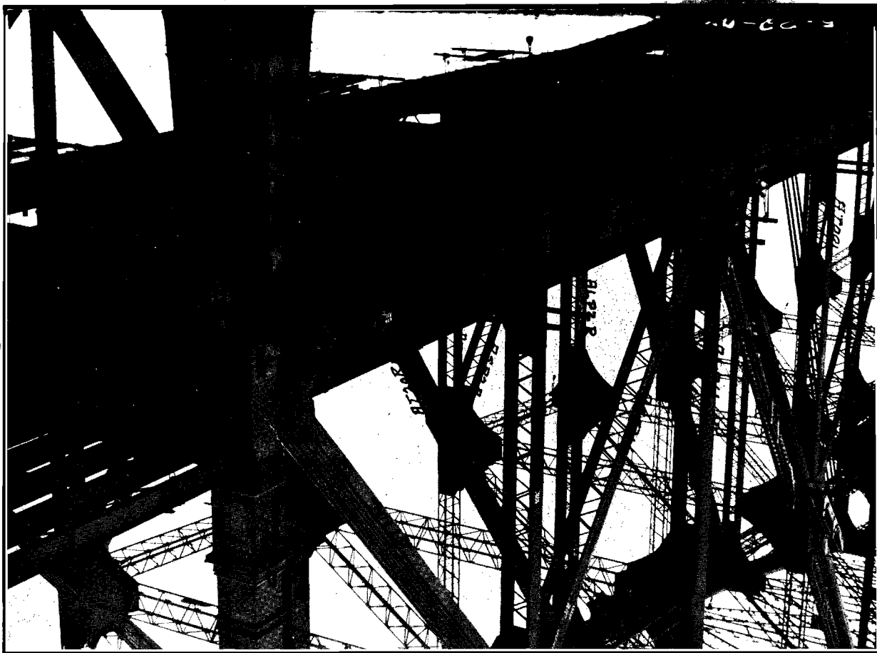
1. Vue des montants extrêmes, tour d'ancrage, et de partie des trois premiers panneaux de la ferme de gauche, bras d'ancrage. Remarquer les échafauds de rivetage en dessous des jointures de la membrure du fond. Le 22 mai 1907.
