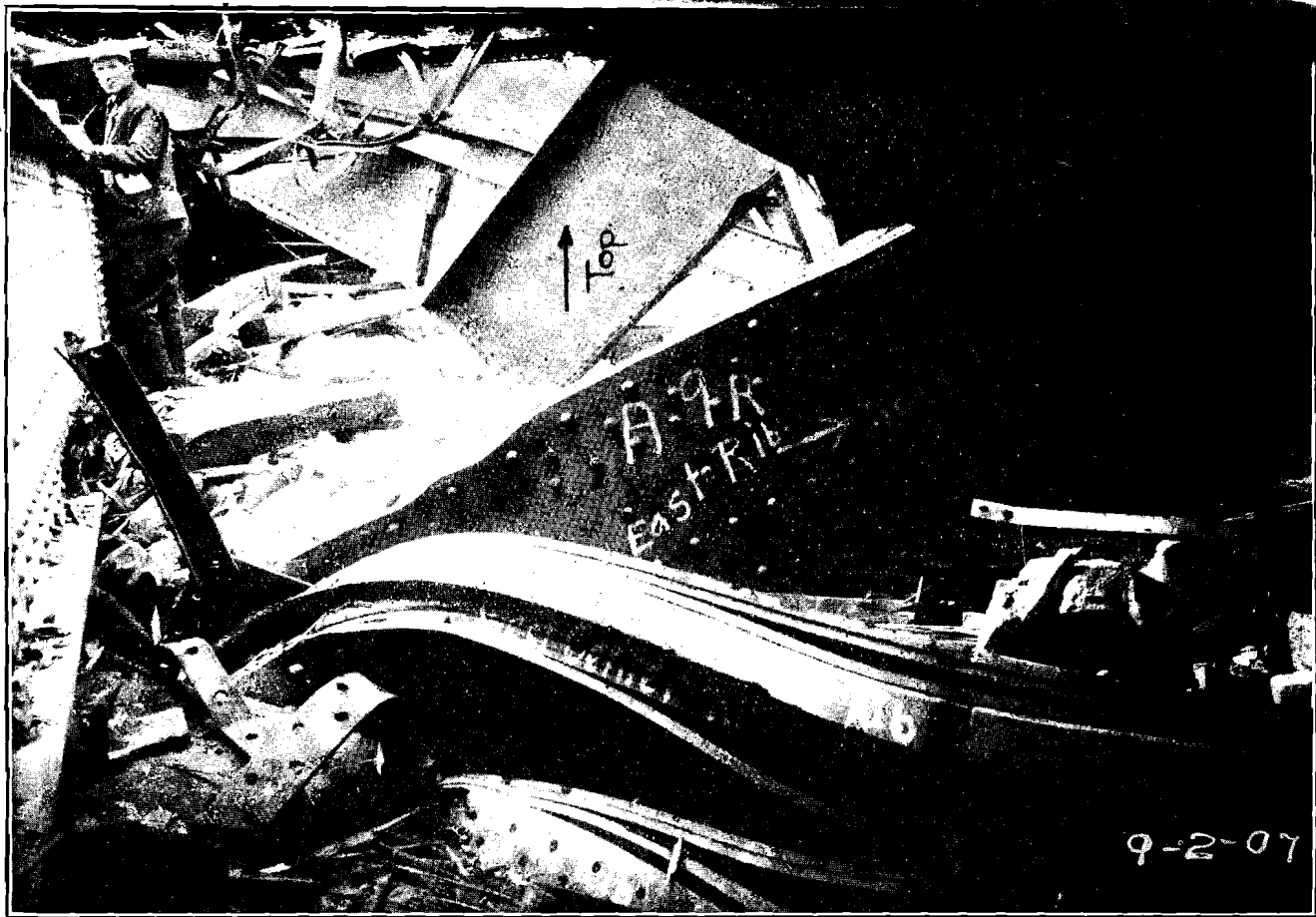
19. Vue des débris de la plate-bande 9, ferme de droite, bras d'ancrage. Remarquer la déflexion des nervures qui atteint presque 180 degrés, au voisinage de la barre de treillis au premier plan, et la membrure a été renversée. La plate-bande inférieure à la gauche de la photographie est A-7-R. Le 2 septembre 1907.
