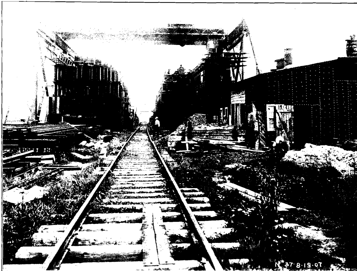
2. Vue du chantier (storage yard) de Belair. Le 19 août, 1907. Remarquer les grues roulantes destinées au chargement et au déchargement des matériaux. ]
