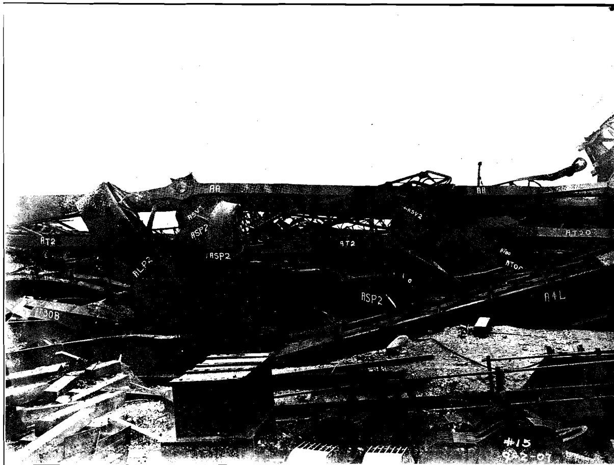
15. Vue indiquant le pied du montant P2L. Remarquer comment les nervures de ASP2 ont abîmé le couvre-joint P4L, à quelque étape de l'écrasement ; le bloc de support (camber block) au premier plan, et la condition du raccord (link) reliant AT2 et AT20.
