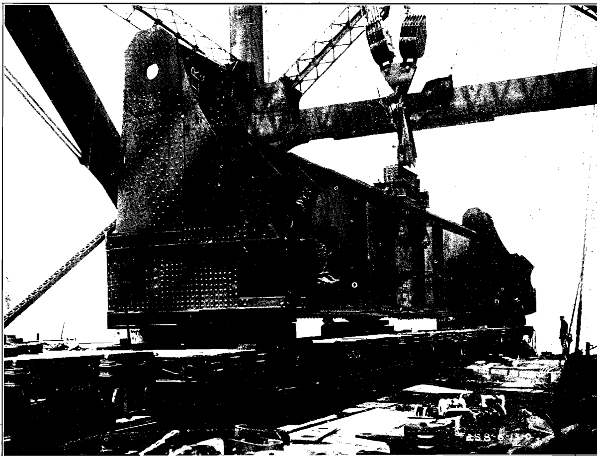
28. Vue de la poutrelle extrême du tablier de la travée suspendue. Le 13 juin 1907
