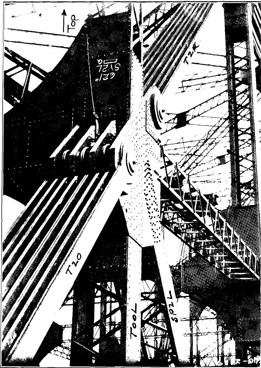
15. Vue de l'intersection des âmes entre les panneaux 3 et 4, bras de console, ferme de gauche. Le 12 juin 1907,
