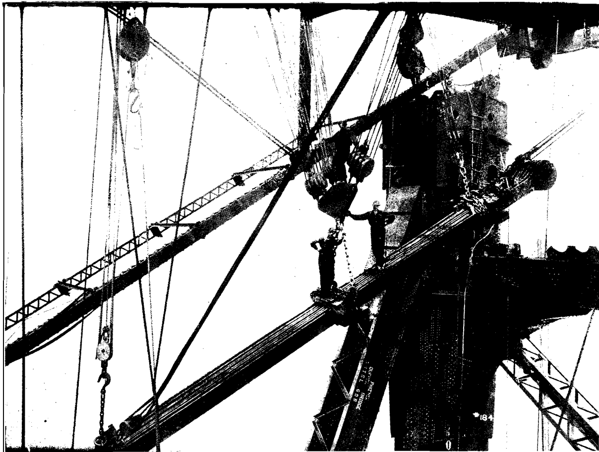
14. Levage d'un groupe de barres-cillets pour plate-bande supérieure. Le 20 juin, 1906. Remarquez les différentes mouffles.
