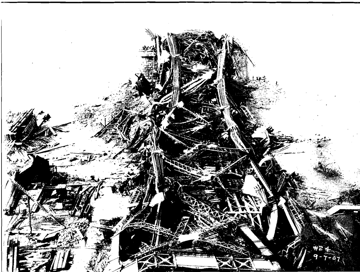
24. Vue d'ensemble prise de la pile d'ancrage, vers le nord, identique à la vue no 22, mais d'une élévation différente. Remarquer les lignes intactes de la membrure supérieure.
