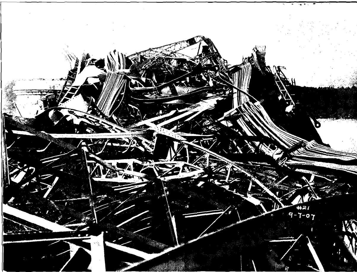
21. Vue d'ensemble, dans la direction de la maîtresse pile. Observer la membrure supérieure, au droit de la photographie.
