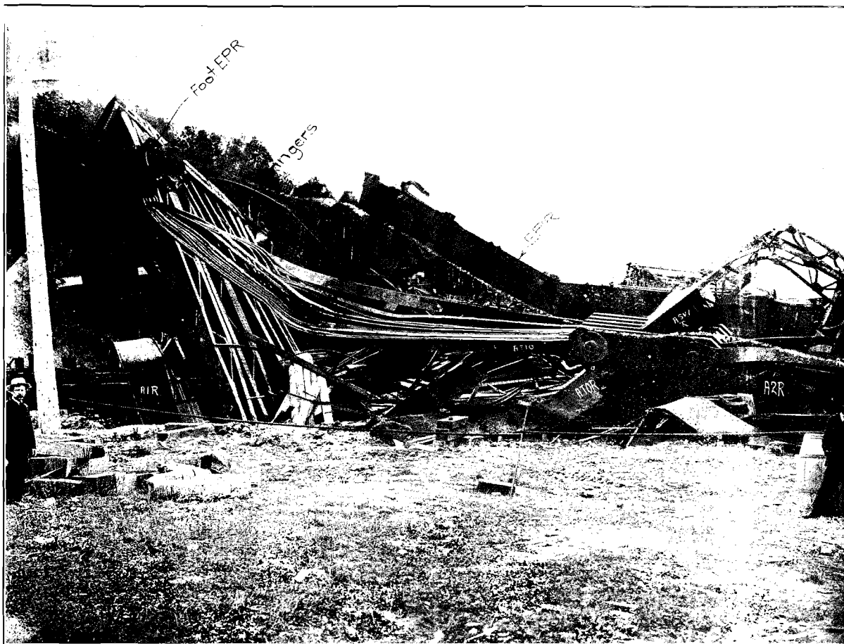
8. Vue montrant le pied de EPR, à gauche. Remarquer le flambage de la plate-bande A1R. D'autres vues de cette membrure figurent dans la Pièce 35 et l'appendice no 12. Observer le système des longcrons. ASP1R, au premier plan s'est tordu et a pénétré à travers les nervures de A2R qui repose presque à angle droit avec sa position primitive.
