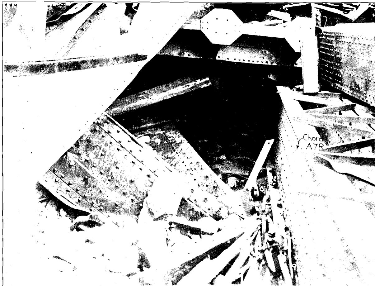
11. Vue dans la direction du nord, indiquant partie de la flexion à 180^\circ dans l'extrémité nord (primitive) de A9R. Remarquer la position de A7R.
