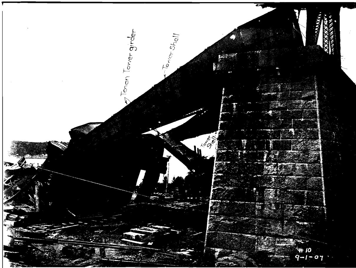
10. Vue prise de l'ouest, au voisinage de la pile d'ancrage. Observer les cuirasses des tours, les boulons d'ancrage arrachés de la maçonnerie et la brisure de la poutre à tenon qui transférait à son ancrage la réaction horizontale contre la pression du vent.
