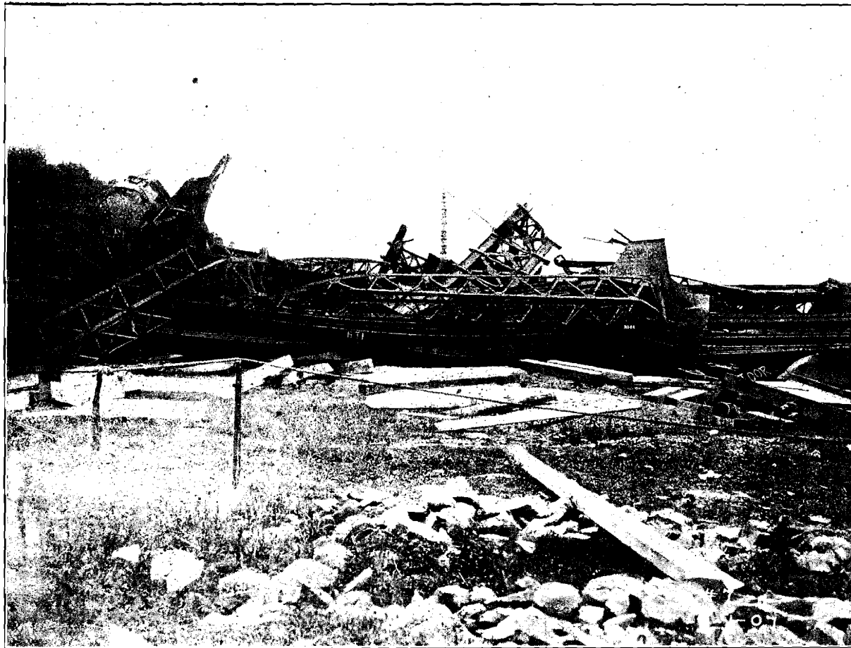
7. Vue près de la cime de la colonne PIR. Remarquer la ligne des barres à ceil diagonales ATi et les barres-cèilletts de la plate-bande supérieure AA.
