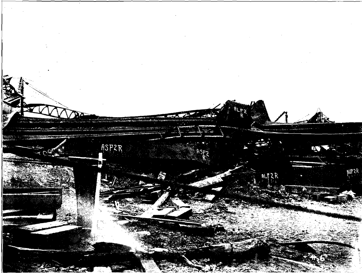
6. Vue du pied du montant P 2 R. Remarquer les déformations de ALP 2 R, ASP 2 R et AUP 2 R, constituant un montant complet.
