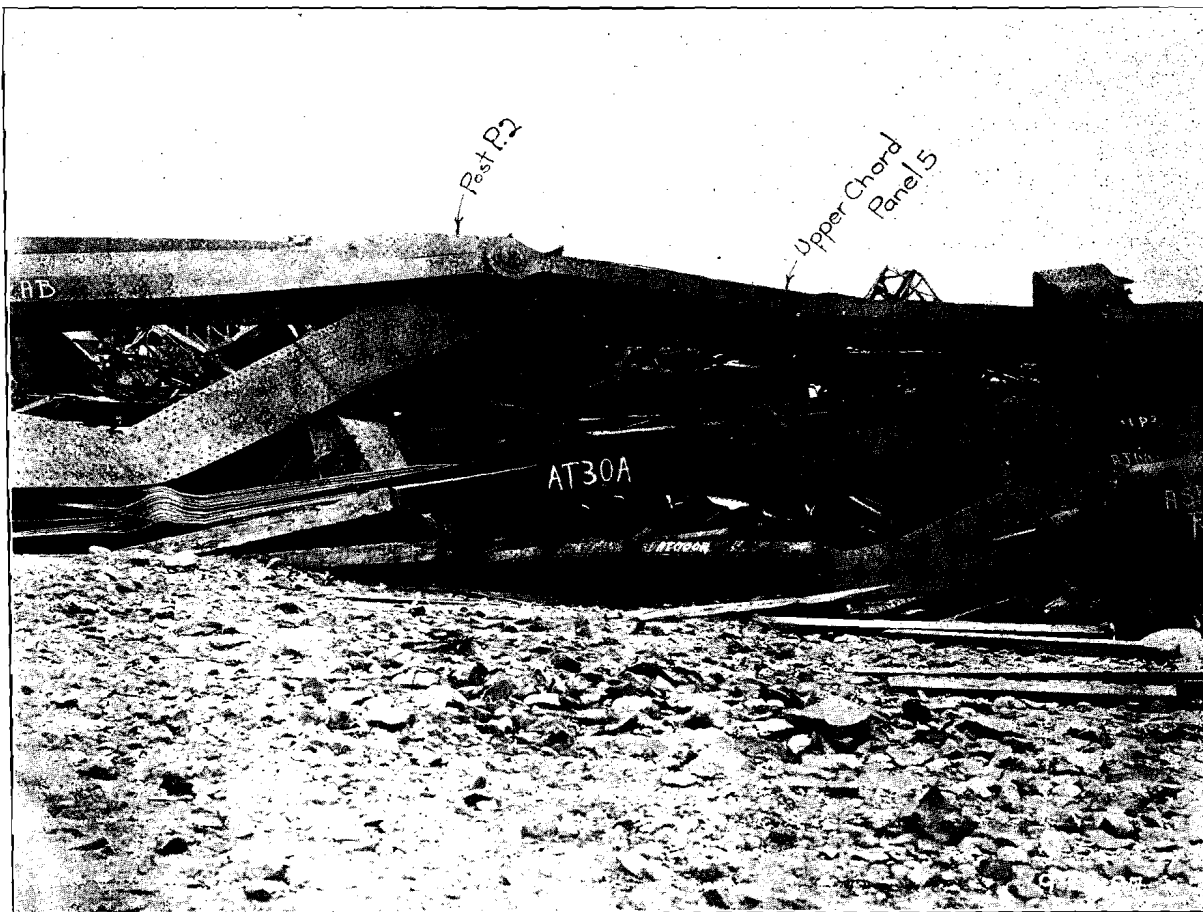
5. Vue du sommet du montant P2R.
