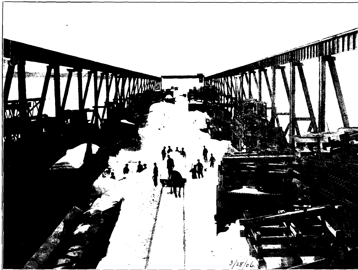
1. Vue du chantier (storage yard) de la Chaudière. Le 28 mars, 1906.
