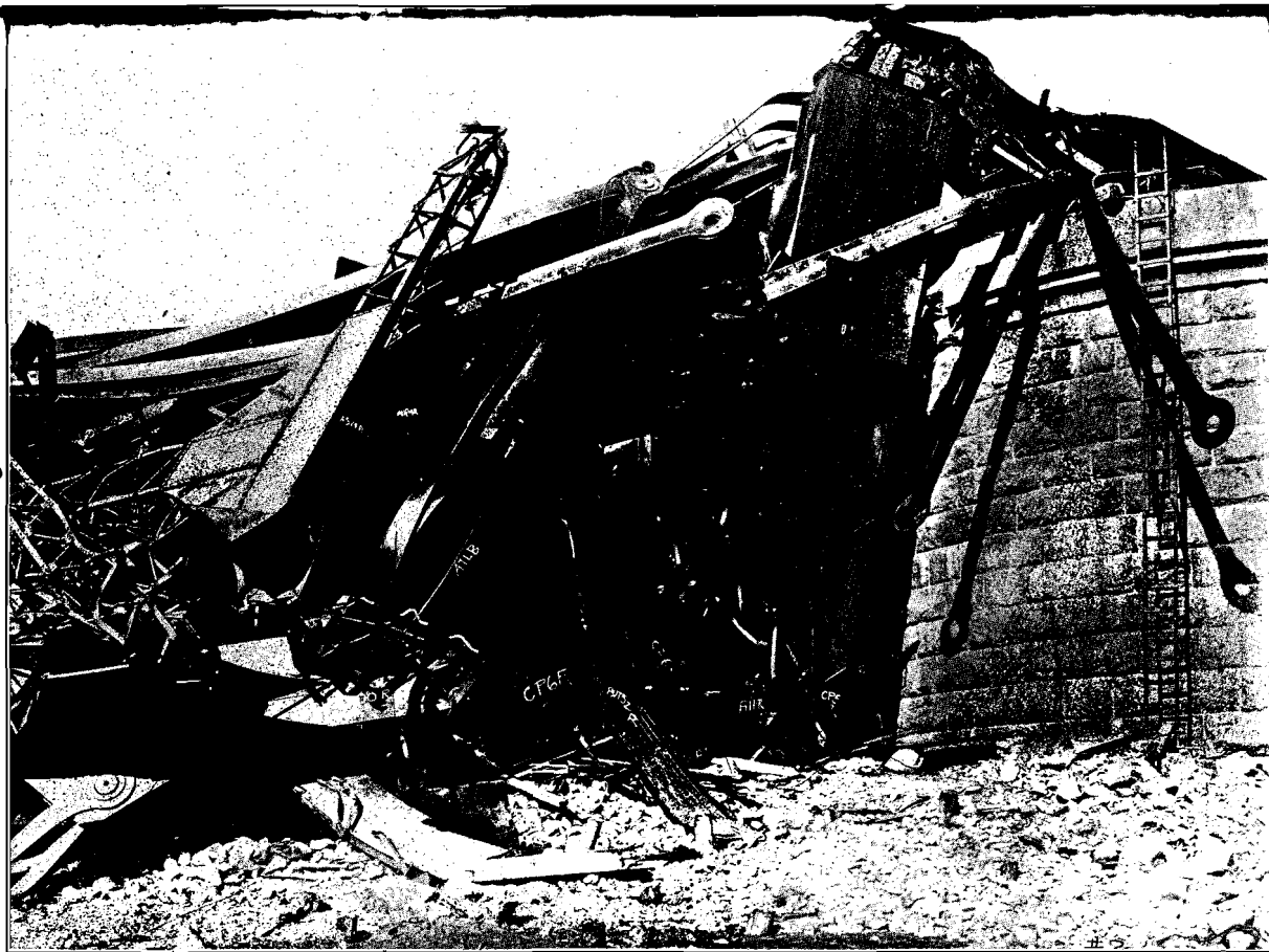
2. Vue prise de l'est, et montrant les débris, à l'intérieur de la maîtresse pile. Observer la condition de CP5 debout, dans la cavité creusée par le sabot ; les ruines de CP4 sur le sommet de la pile et la position de P4 repoussé violemment à l'intérieur de CP.
