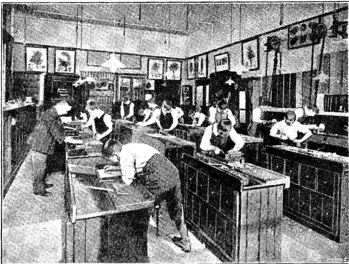
ATELIER DE MENUISERIE : ECOLE DU JOUR PRÉPARATOIRE AUX MÉTIERS DE WOODHOUSE.
