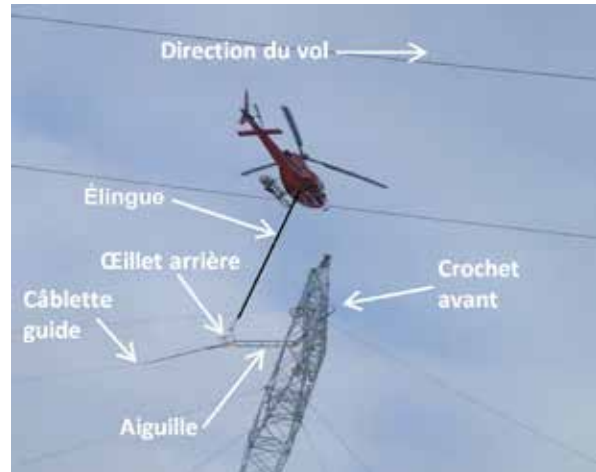
Figure 2. Approche du pylône
