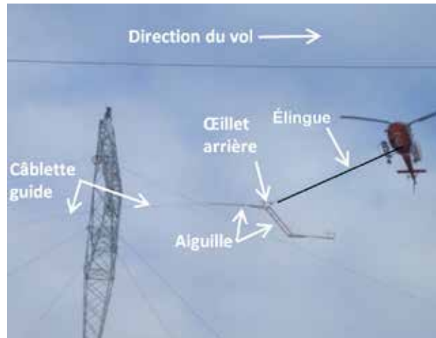
Figure 4. Traction de la câblette guide
