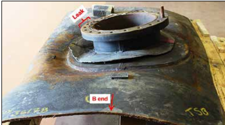
Figure 5. Photographie après la dépose de l'enveloppe externe de la citerne pour mettre à découvert la soudure raccordant le renfort de la buse du trou d'homme à la citerne. À noter : la déformation près de l'emplacement de la fuite.
