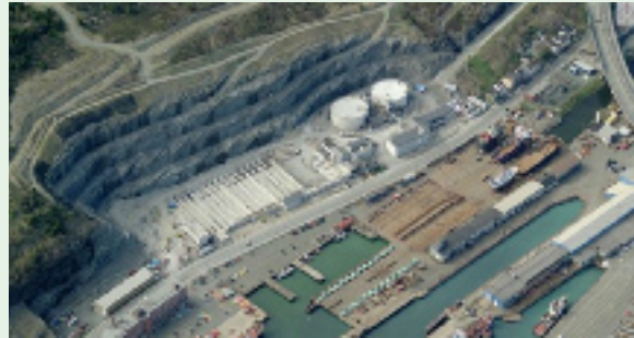
Usine de traitement des eaux usées de la ville de St. John's
