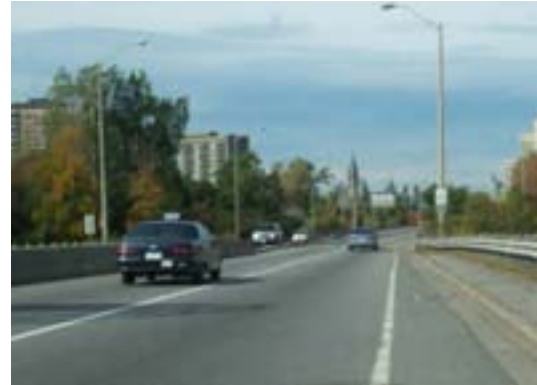
Figure 138. – Passerelle à haubans surélevée (vue du point d'observation clé 17).
