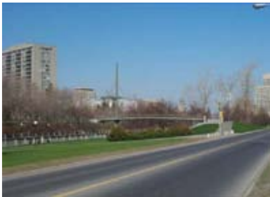
Figure 137. – Passerelle à haubans surélevée.
