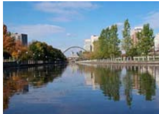
Figure 140. – Passerelle à arc simple surélevée.
