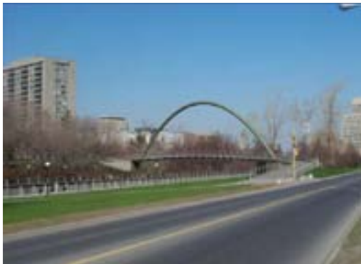
Figure 139. – Passerelle à arc simple surélevée.
