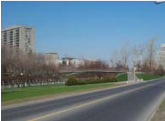
Figure 135. – Passerelle à structure rigide (à appui simple).
