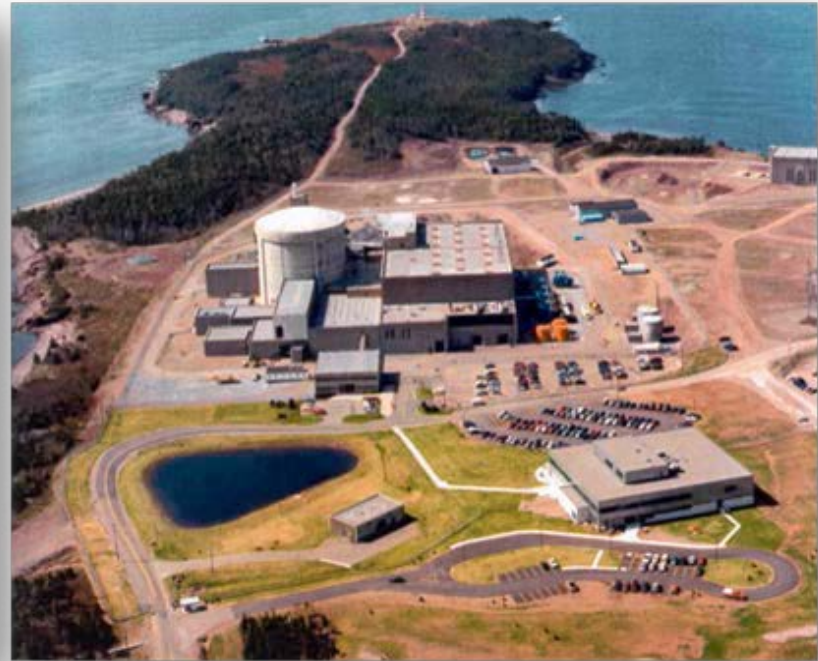
Centrale nucléaire de Point Lepreau (Énergie Nouveau-Brunswick), Point Lepreau, N.-B.
