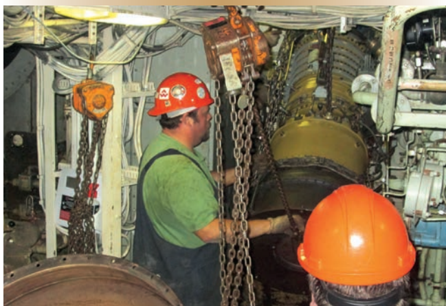
Figure 8. Le nouveau moteur est déposé délicatement dans l'enceinte.
