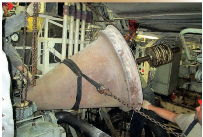
Figure 4. Enlèvement du cône de diffuseur.
