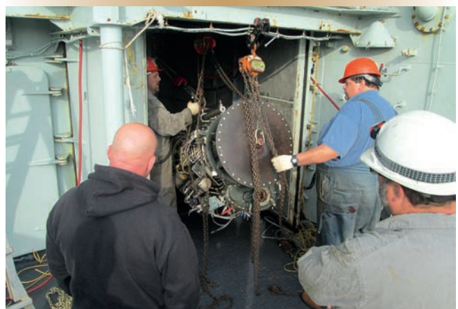
Figure 5. Enlèvement du moteur par les portes de dérivation.
