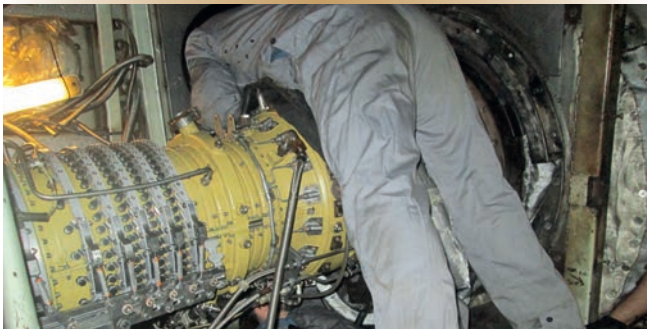
Figure 9. Russ Brown, le RTF d'Allison Gas Turbines s'assure que l'alignement entre l'arbre de sortie du moteur et le boîtier d'entraînement est parfaitement droit.
