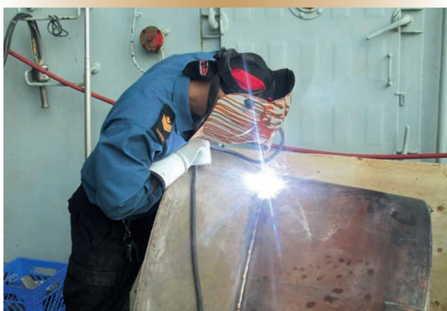
Figure 7. Le M 2 Boz soude le diffuseur d'échappement.
