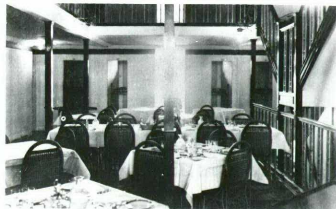
5. Les constructeurs du Zeppelin n'avaient jamais entendu parler de la cabine "boîte à sardine"! Cette photo de la salle à manger du R100 témoigne bien de l'immensité des dirigeables dans les années 30. Le R100 comptait 25 confortables cabines à deux couchettes, toutes situées devant les moteurs dans la nacelle de sorte qu'elles étaient pratiquement insonorisées et exemptes de vibrations.
