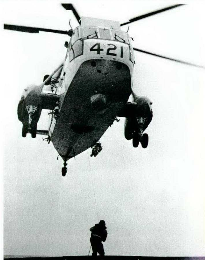
“Un des membres de l'équipe du pont d'envol met ce fil à la masse du navire et le fixe au câble du hale-bas, ...”
