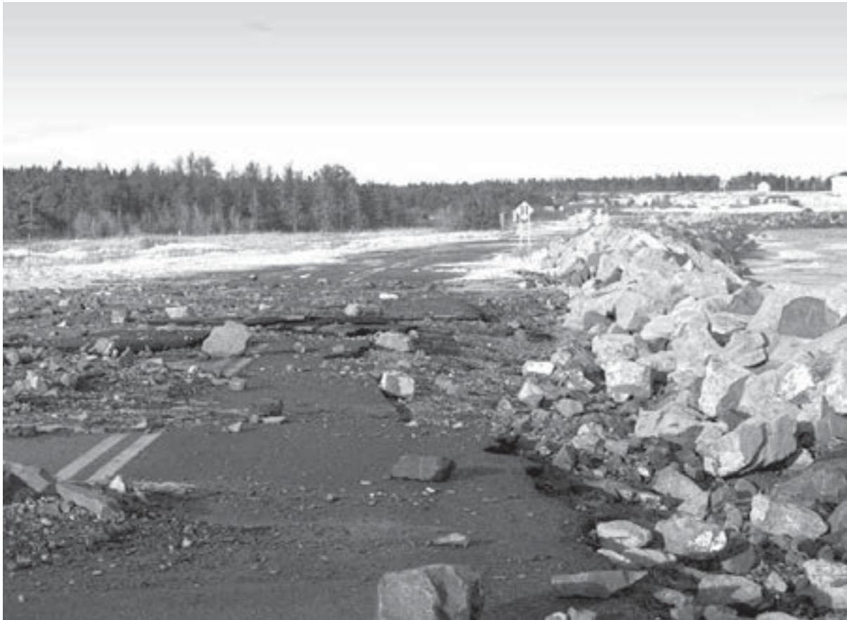
Dommages subis à répétition par la route du Banc Parcs Canada / D. Sigouin
