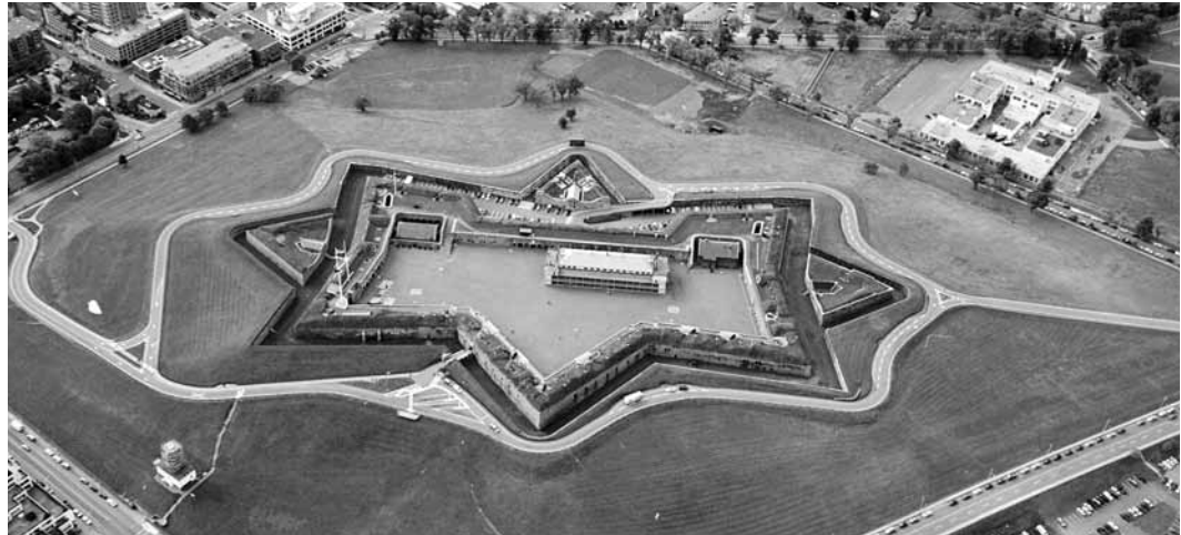
Vue aérienne de la Citadelle-d'Halifax. Ship to Shore Photography/Parcs Canada 2005
