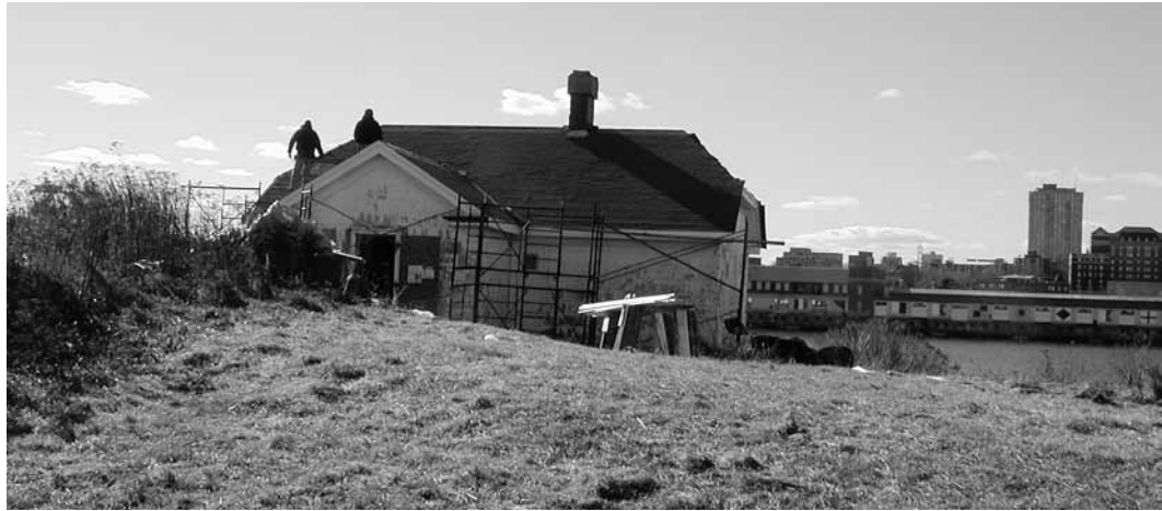
Réparation de la maison du gardien du phare, Île-Georges. Soonya Quon 2005
