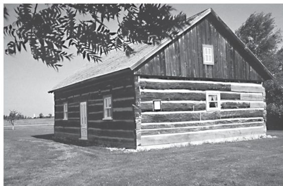
Maison de bois construite selon la technique « pièce sur pièce » Parcs Canada / Sophie Grenier
