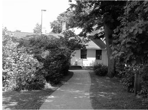
Entrée latérale et allée du terrain de stationnement. Parcs Canada, 2001
