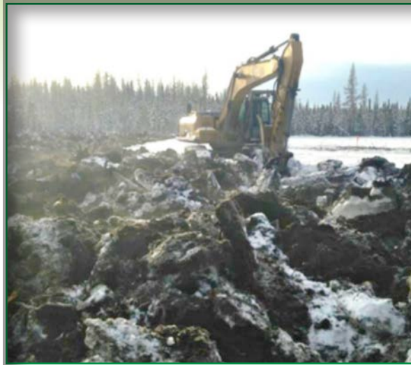
Figure 7a. Traitement du sol par formation de monticules inégaux et meubles à l'aide d'une excavatrice et d'un godet
