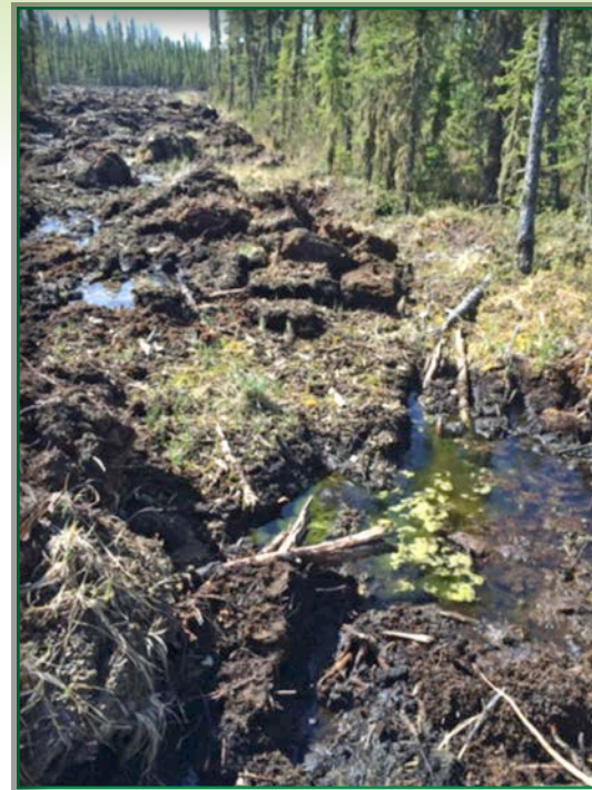
Figure 6. Formation de monticules réalisée au moyen d'une excavatrice et d'un godet
