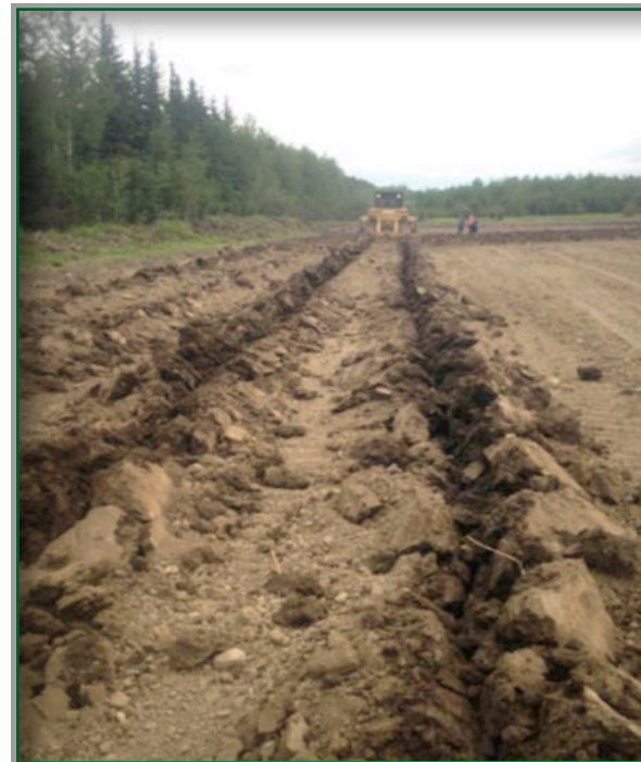
Figure 5a. Bulldozer auquel sont fixées deux dents de défonceuses pour travailler un sol extrêmement sec et compacté
