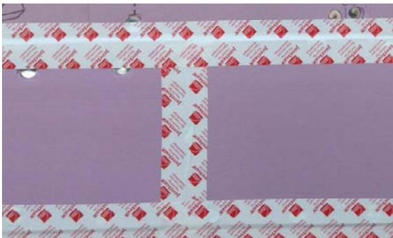
Figure 7 : Gros plan sur le système pare-air extérieur utilisant une isolation rigide en polystyrène extrudé avec des joints étanches, sur une maison de démonstration de Winnipeg, 2015. Référence photographique: Gary Proskiw
