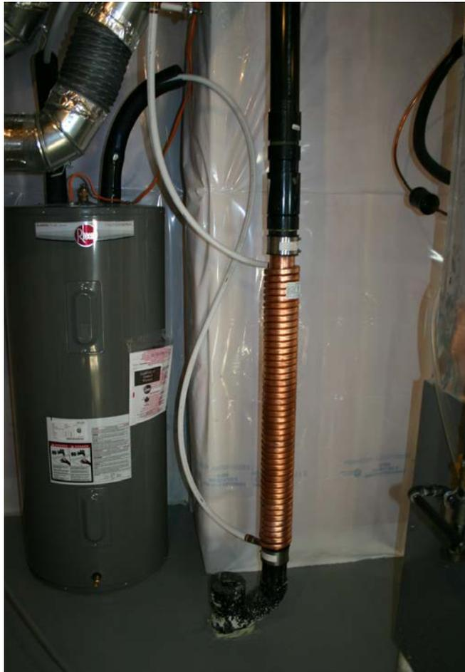
Figure 21 : Système de récupération de chaleur des eaux de drainage installé dans une maison d'essai LEEP.
