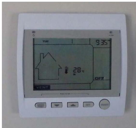
Figure 20 : Image d'un contrôleur avancé installé dans une maison d'essai LEEP. Référence photographique: Gio Robson
