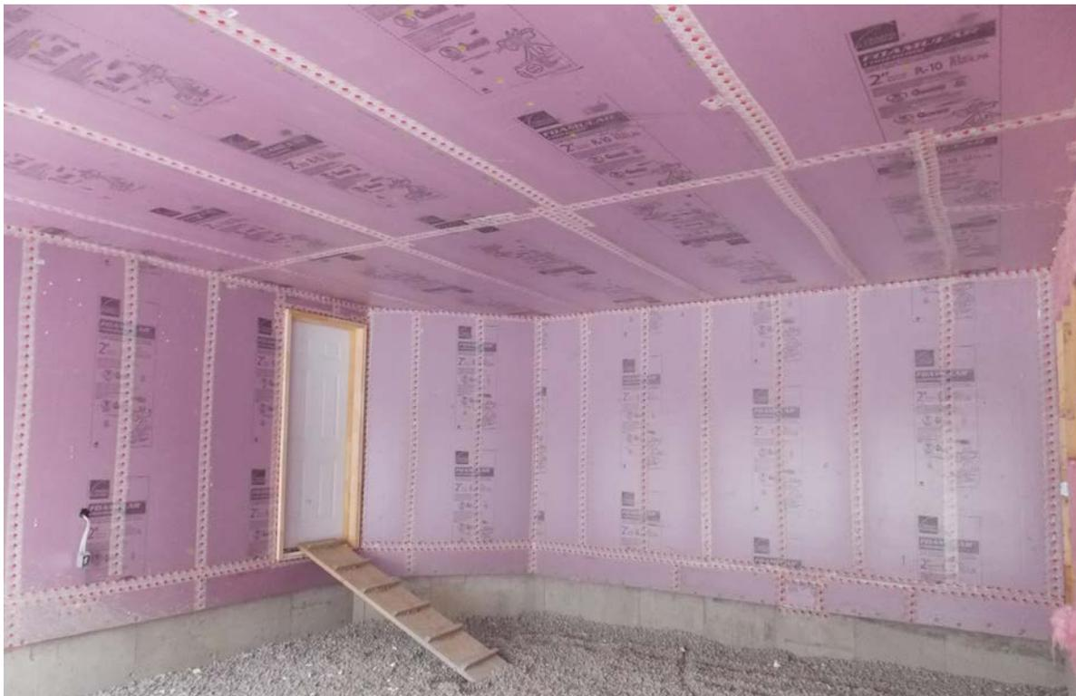
Figure 14 : Exemple d'un revêtement en panneaux de mousse appliqué à la sous-face d'un plancher situé au-dessus d'un garage. Référence photographique: Owens Corning Canada
