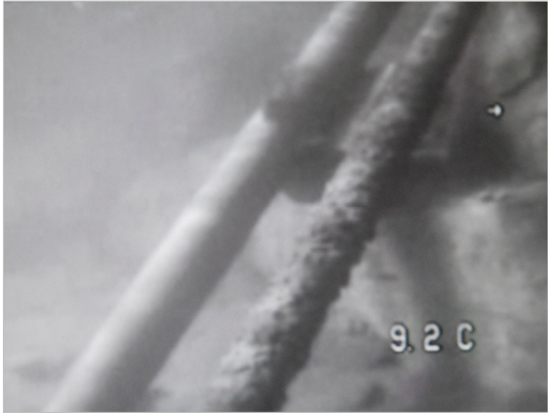
Piétage video acquis près de la conduite d'entrée d'eau au T-Lake .
