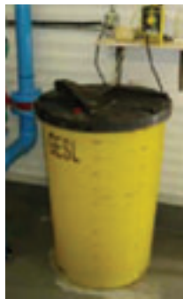
In-line chlorinator (S. Schurman, 2006)
