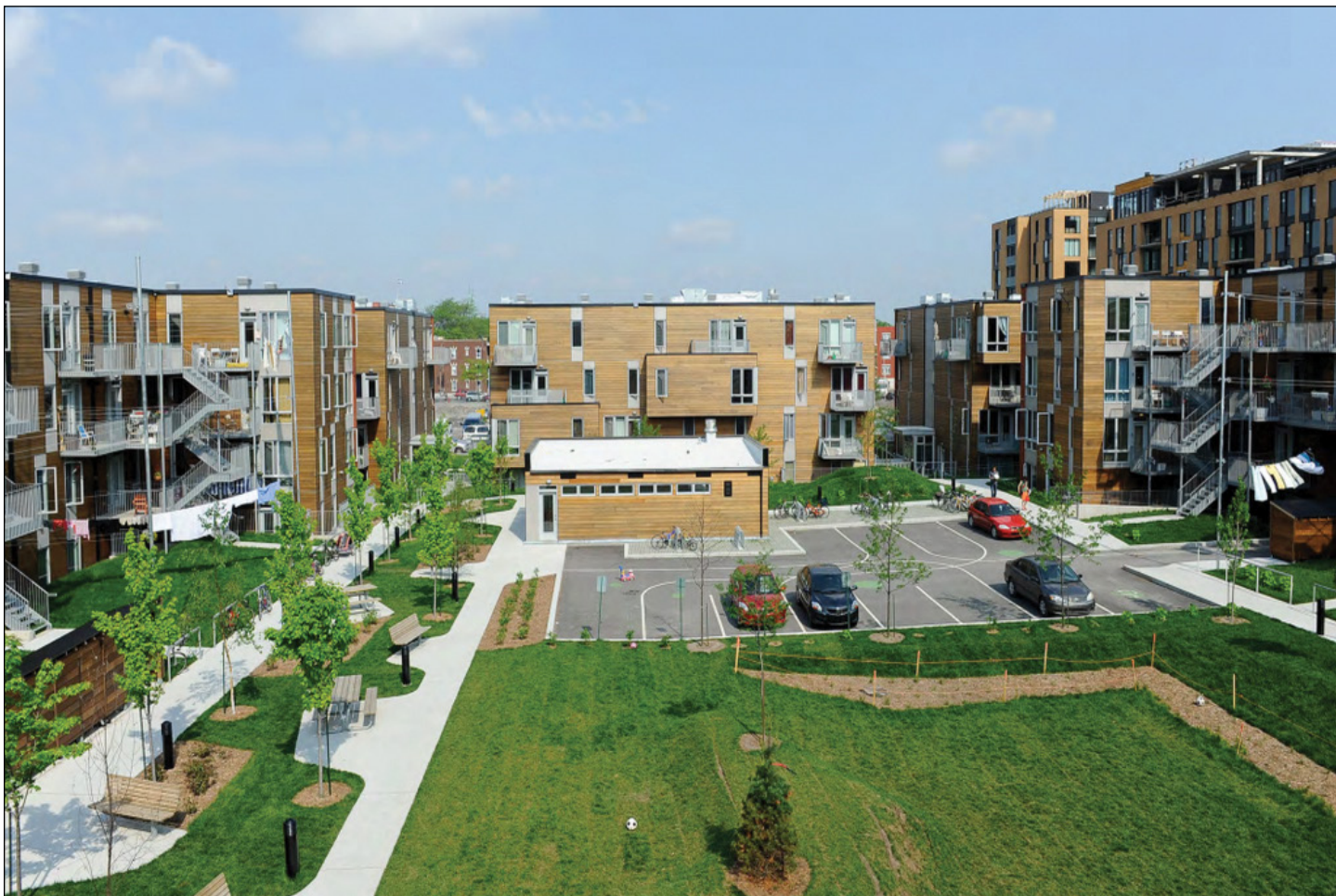
Figure 10 Bassin de rétention des eaux de surface situé au coin inférieur droit (Source : Nikkol Rot)
