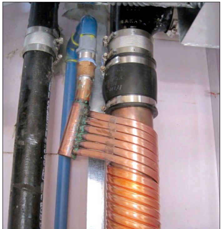
Figure 7 Dispositif de récupération de la chaleur des eaux ménagères (Source : L'CEUF s.e.n.c.)
