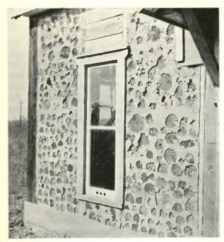
Bouts de rondins de cèdre scellés dans le béton.
