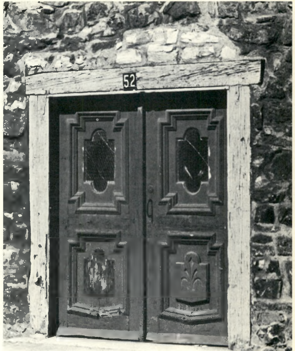
A Québec, cette porte à deux battants datant de la fin du 19 e siècle est entourée de murs de moellons réguliers vieux de 200 ans.
