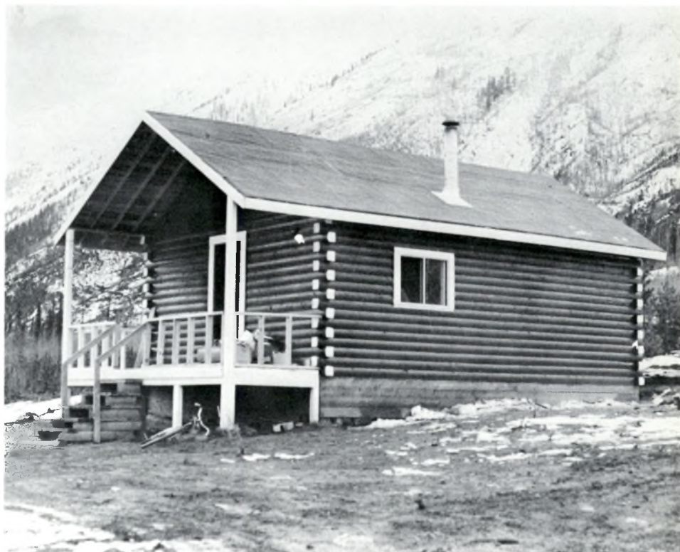
Une maison de bois rond que construit la British Columbia Association of Non-Status Indians constitue une bonne habitation.
