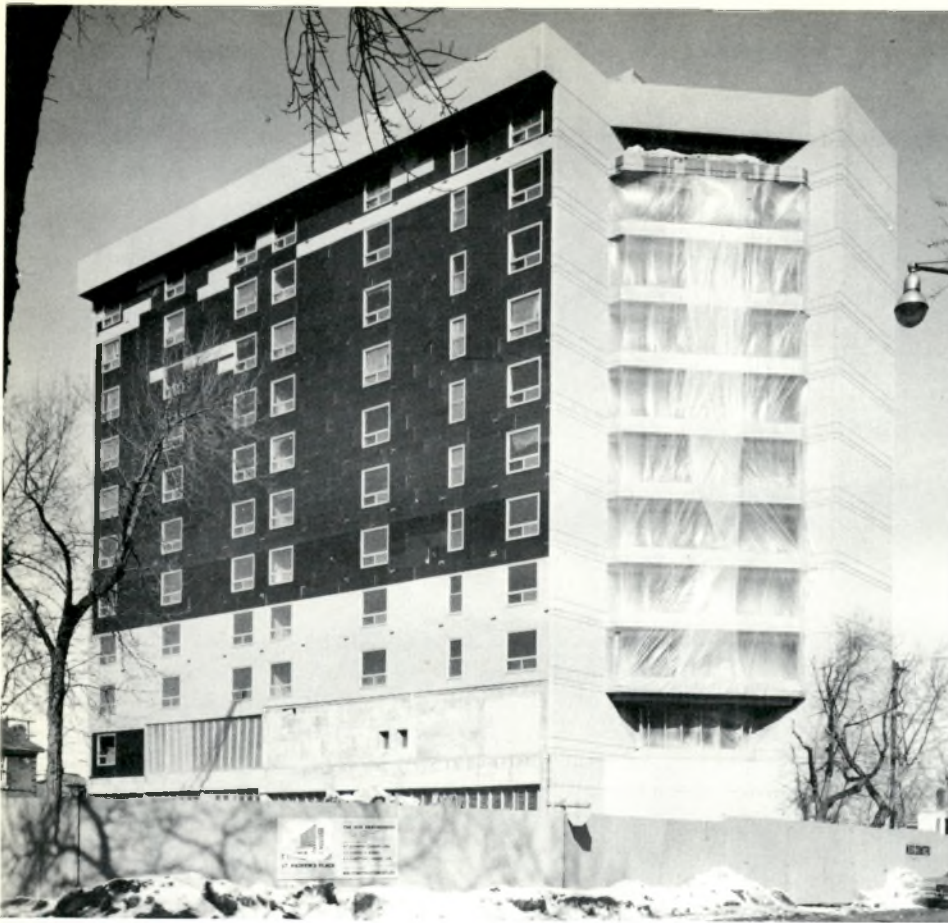
St. Andrew's Place en voie de construction. La tour qui fait partie de cet ensemble pourra être occupée vers le 1er juin 1975 et le reste, l'automne prochain.
