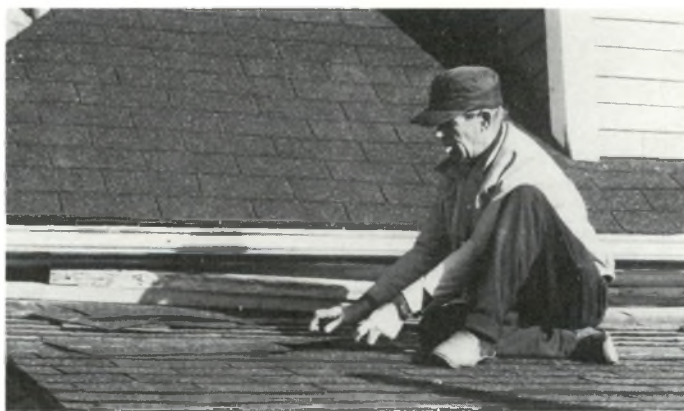
Les bardeaux usés sont enlevés . . . . . . pour faire place à des nouveaux.
