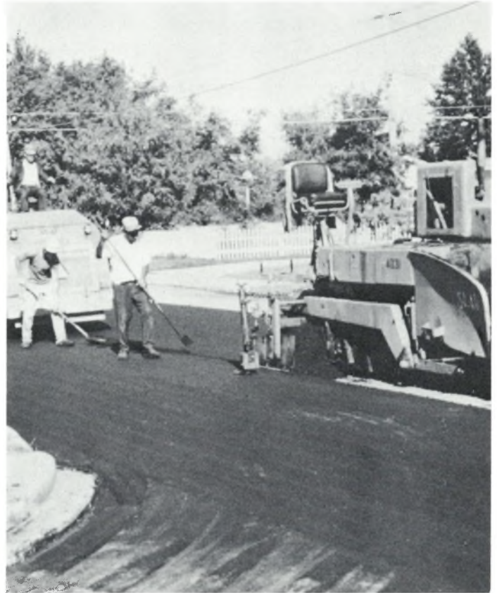
Travaux de recouvrement d'asphalte en cours.
