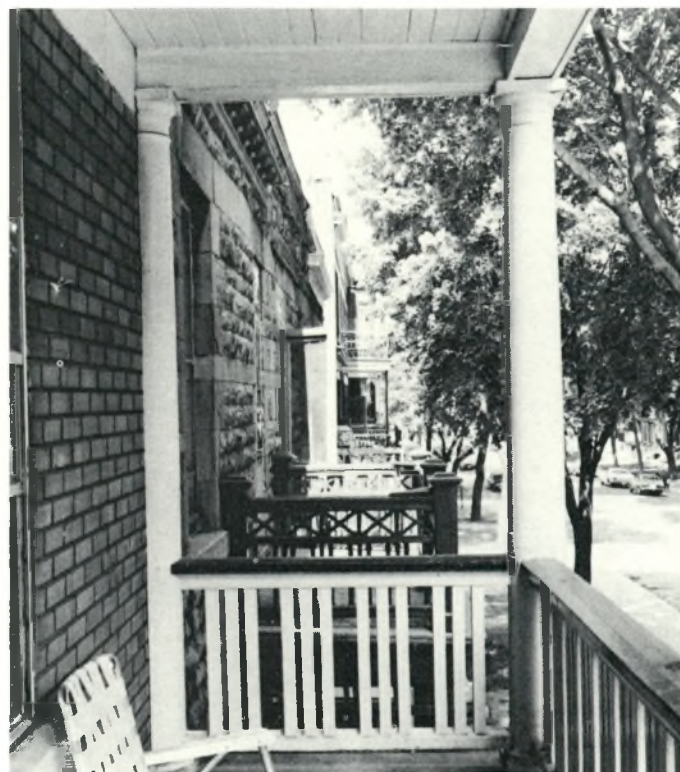
Les balcons ont été repeints.
