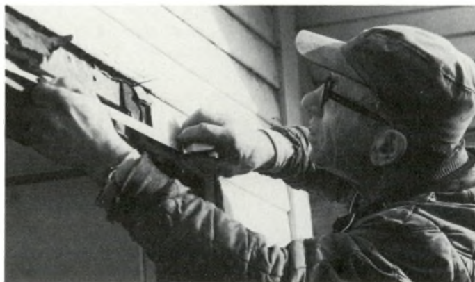
Un menuisier prend les mesures en vue de la réparation d'un parement de bois.
