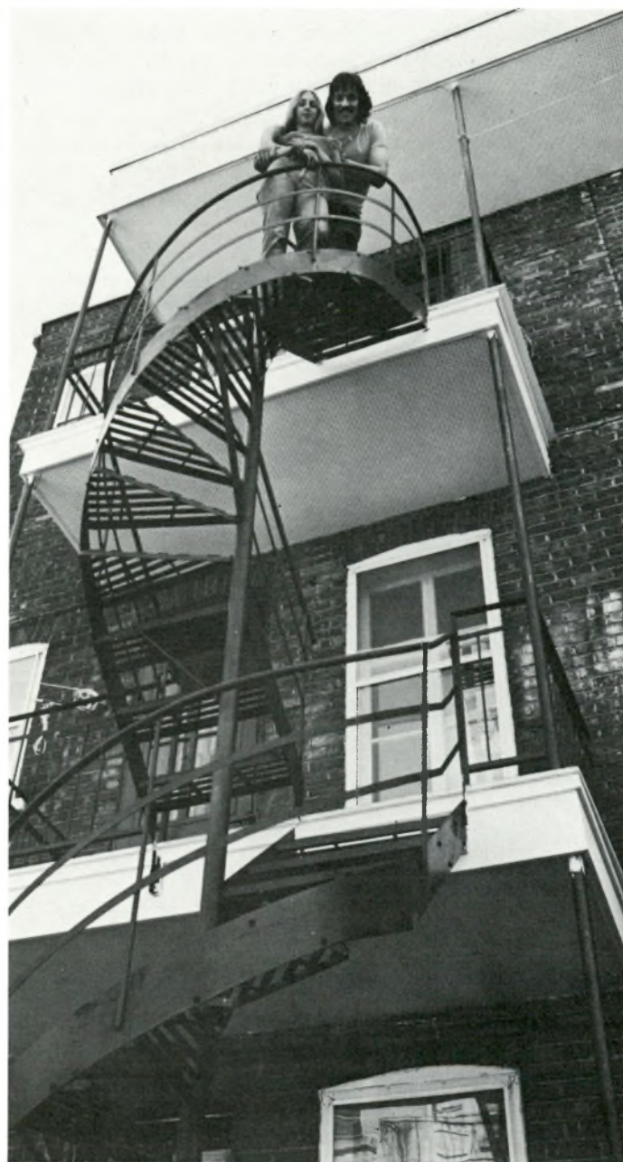
La restauration des balcons arrière faisait partie des travaux à effectuer.
