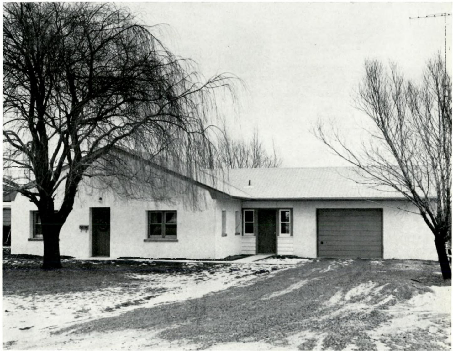
Maintenant que les travaux de restauration sont terminés, cette maison a un nouveau parement extérieur, un toit à pignons et un garage à même pour deux voitures. On a refait le nivellement du terrain de façon à améliorer le décor extérieur et à remédier au problème de l'eau. Les propriétaires de tout ce secteur de rénovation urbaine demandent maintenant des prêts semblables à la SCHL en vue de moderniser et de restaurer leur propriété.
