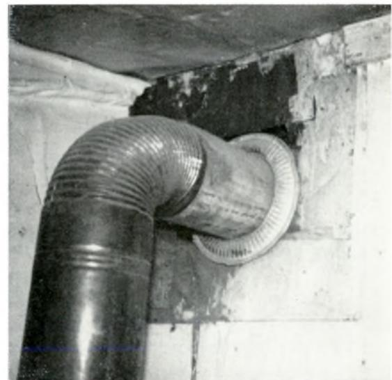
Tuyau de poêle de la cuisinière. Remarquez le mauvais raccordement à la cheminée et la déperdition du goudron.
